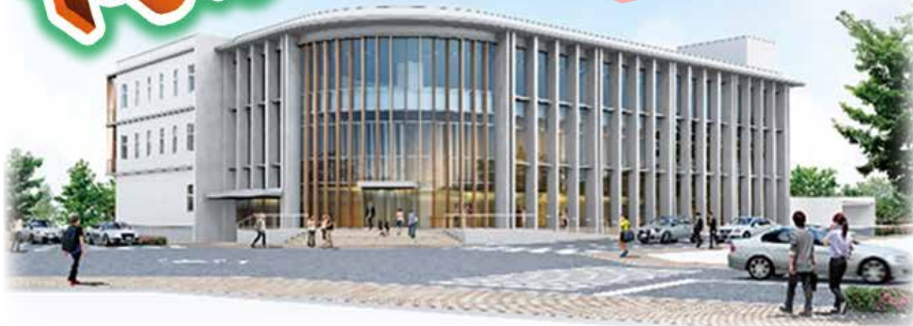
写真：竣工間近な泉野福祉健康センター(福祉健康局より写真とコメントをいただきました)
